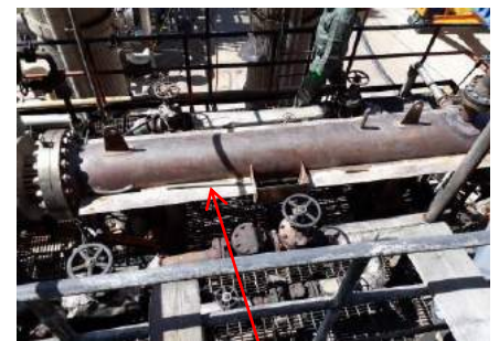
مبدل حرارتی جایگزین شده
