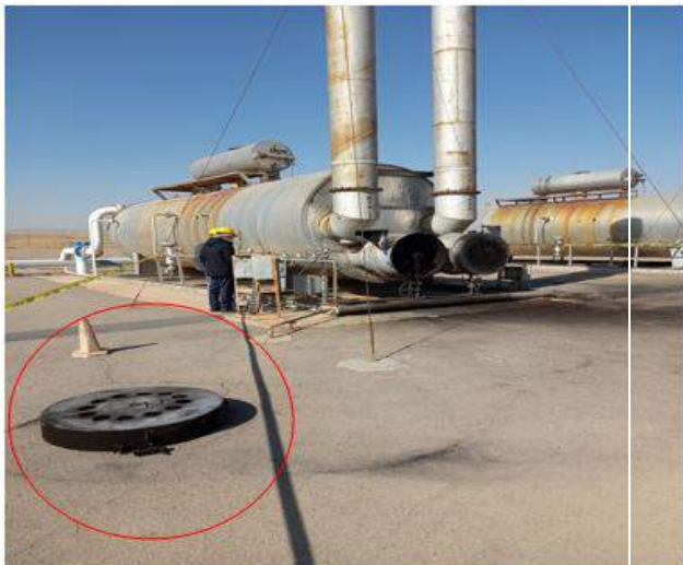
محل افتادن در هیتر در اثر انفجار
